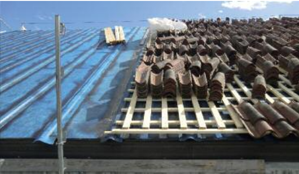
Il tetto della chiesa durante le fasi delle lavorazioni
